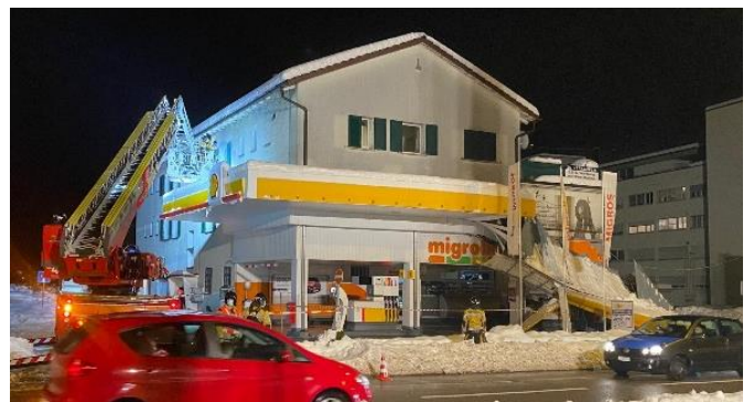
schwerer Schnee wird vom intakten Dachteil entfernt
