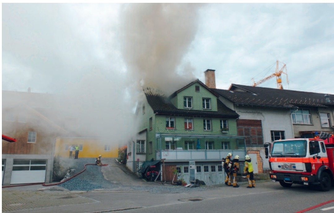
Dachstockbrand, Konstanzerstrasse in Wil
