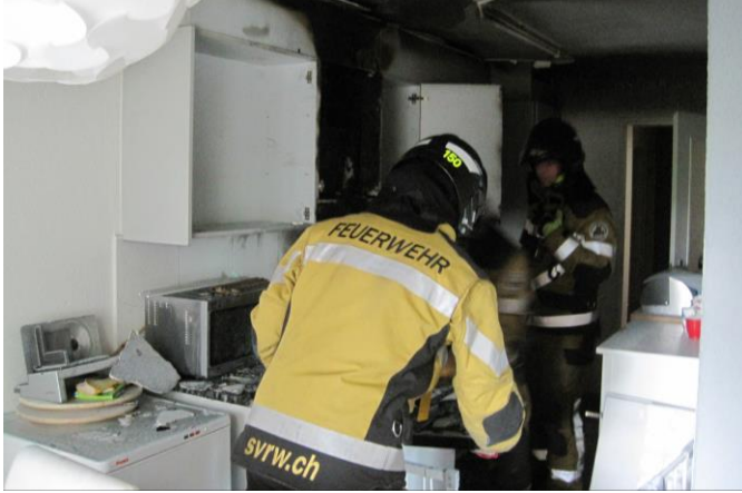
Kontrollarbeiten in der vom Brand betroffenen Küche
