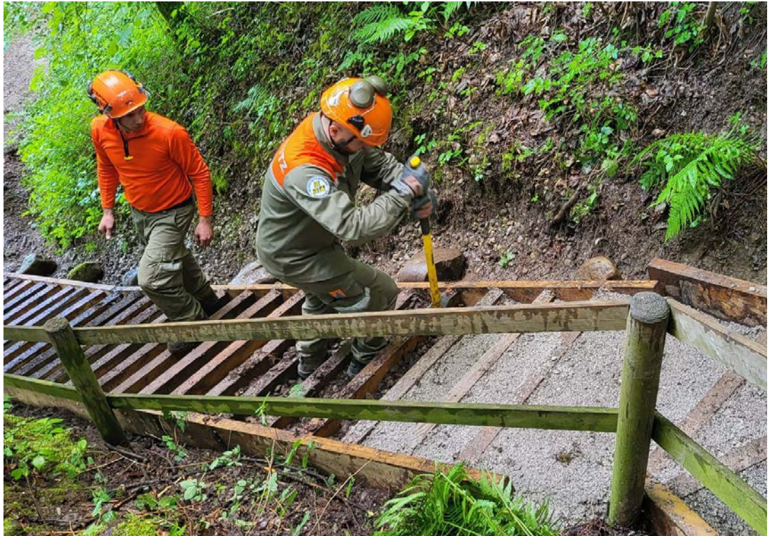
Wanderwegsanierung durch die Pioniere
