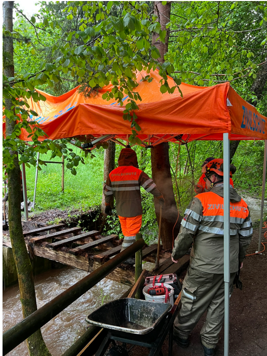
Wegsanierung in Oberuzwil
