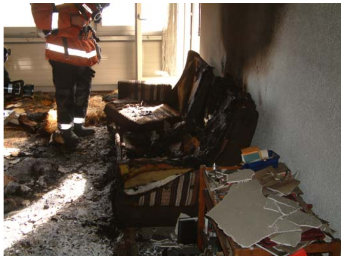
In der Wohnung entstand erheblicher Schaden.
