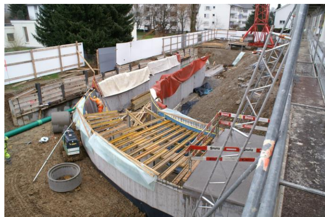
Rampe ins Untergeschoss
