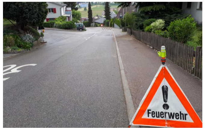
VK-Dienst wegen Wasserrohrbruch und Belagsarbeiten
